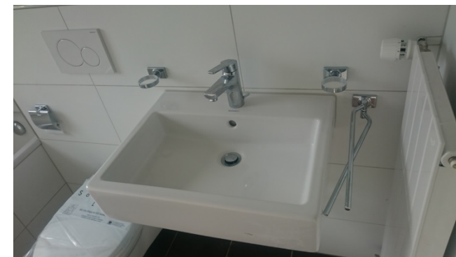
[Foto Baustelle, nachher]
