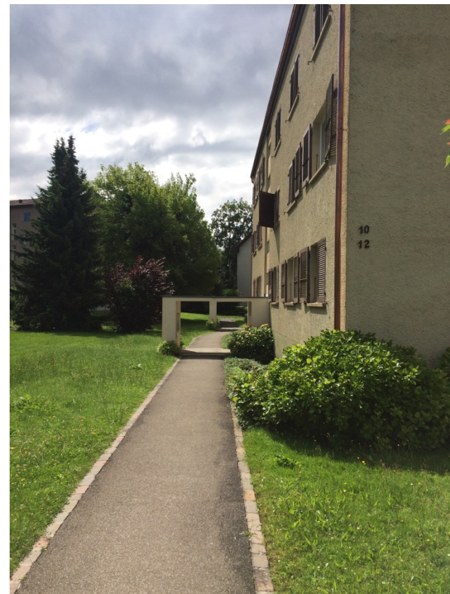
[Foto Baustelle, vorher]
