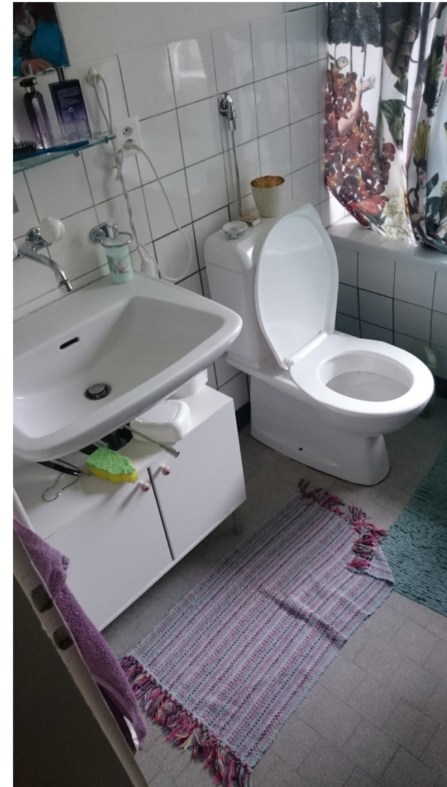
[Foto Baustelle, vorher]
