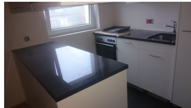
[Foto Baustelle, nachher]
